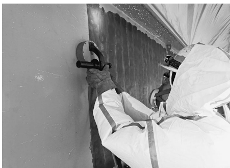
IHはく離機で鋼材と塗膜を分離(上下の写真2点は同事務所提供)
