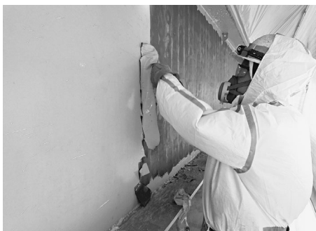
スクレーパーで塗膜かき落とし
